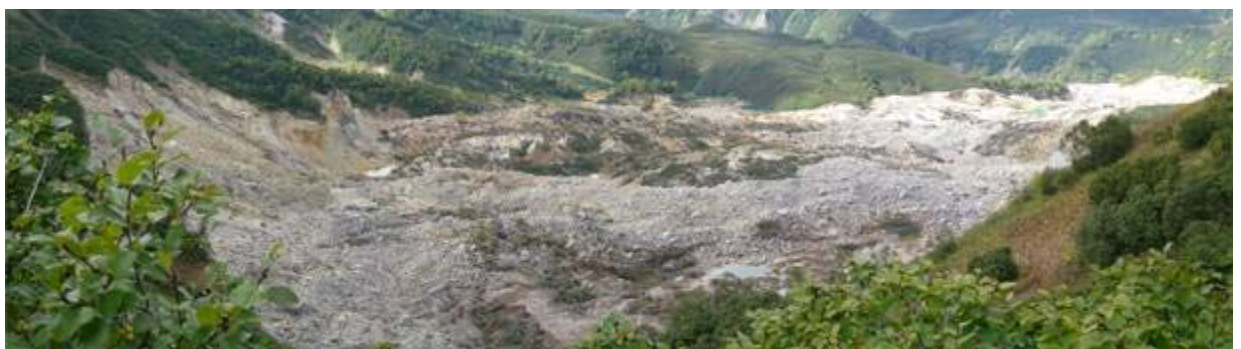
Рис. 6. Общий вид оползня сверху.
