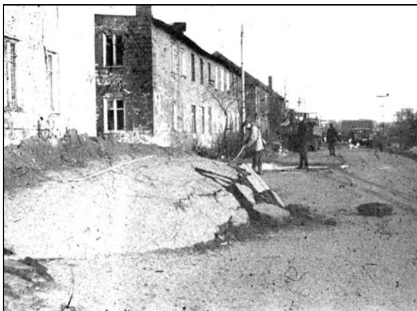
Рис. 1. Вал выпирания, образовавшийся на проезжей части ул. Рябиковская при сходе Рябиковского оползня 1995 г. Фото И.Ф. Делемента
