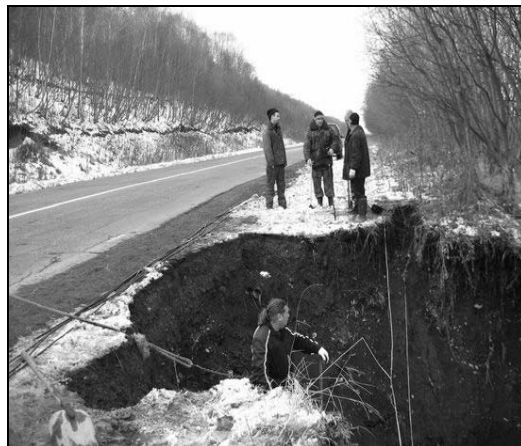
Рис. 2. Ликвидация повреждения телефонного кабеля после схода оползня в долине р. Авача 22 октября 2008 г. на участке между 42 и 43 километром трассы Елизово - п. Зеленый. Фото ИА "Азиатско-Тихоокеанский информационный центр".
