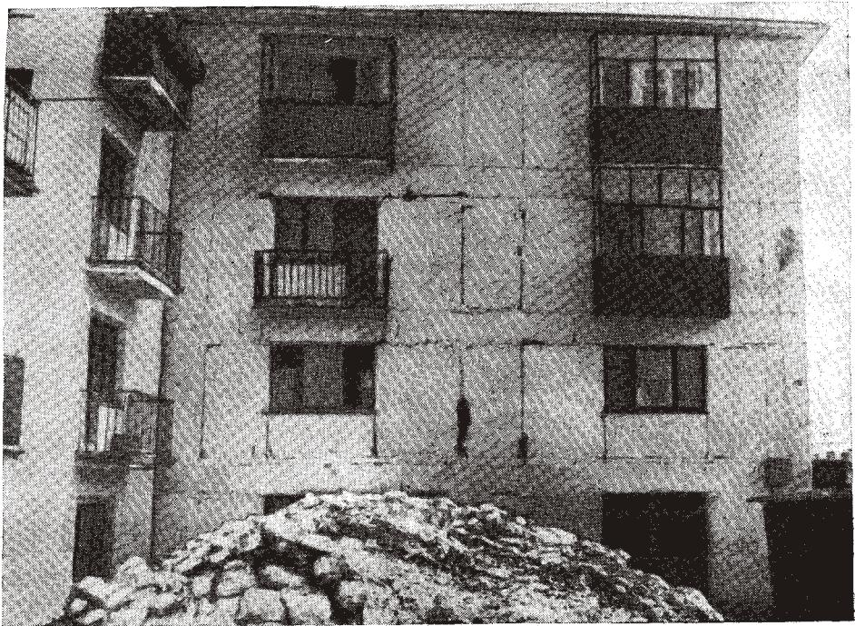
Рис. 5. Повреждение крупноблочного дома (степень повреждения — 2,5).
