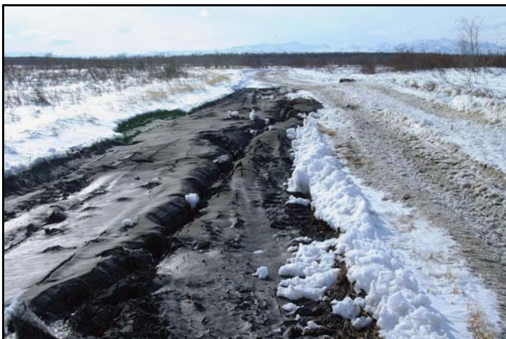
Рис.8 Характерные трещины с выбросами грязи по ним в долине реки Вывенка. (Фото С.Полуэктова)
