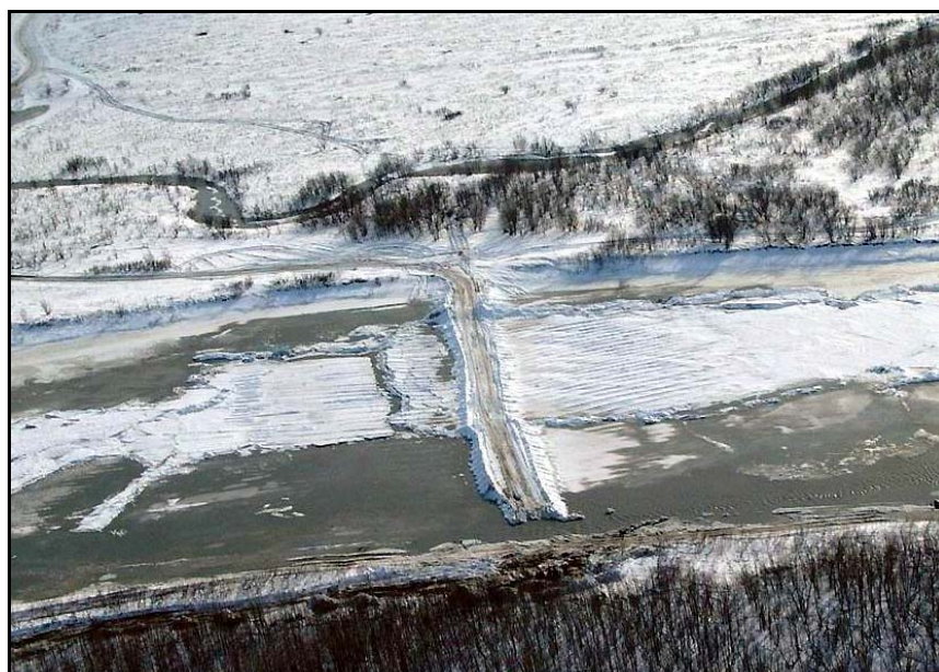
Рис.5 Переправа через реку Вывенка после землетрясения. (Фото С.Полуэктова)
